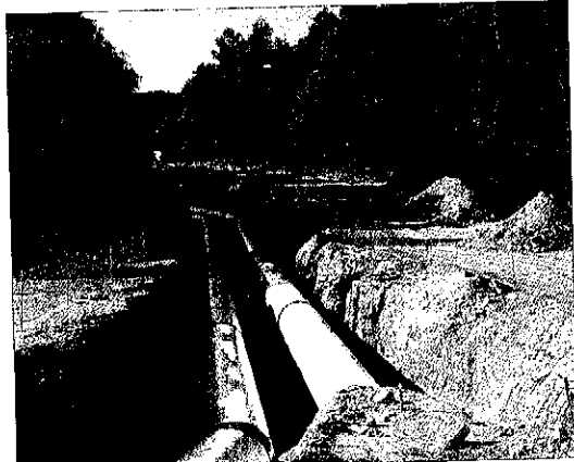
Imatge d'arxiu d'obres al Garrigues Sud.
