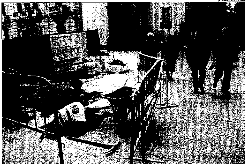
Obres de connexió de serveis ahir entre la plaça i el carrer Major.
