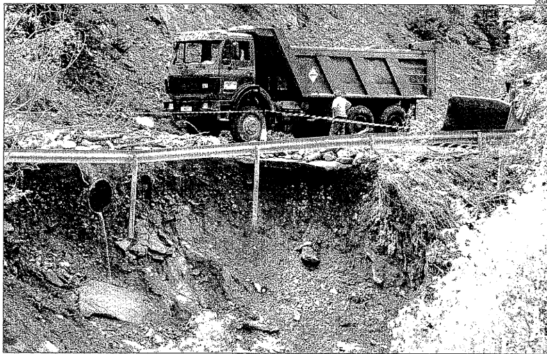
L'accés a Port-Ainé, després d'un desprendiment al juliol, s'està reparant i obrirà amb la temporada.
