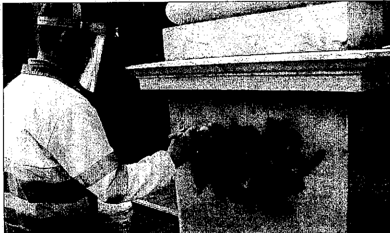
Un operari d'Inet aplicant un producte decapant a una pintada abans d'usar l'aigua a pressió.
