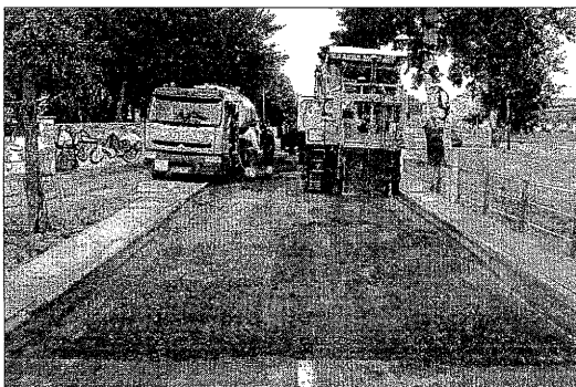
Els treballs de millora al carrer Migdia de Tàrraga.
