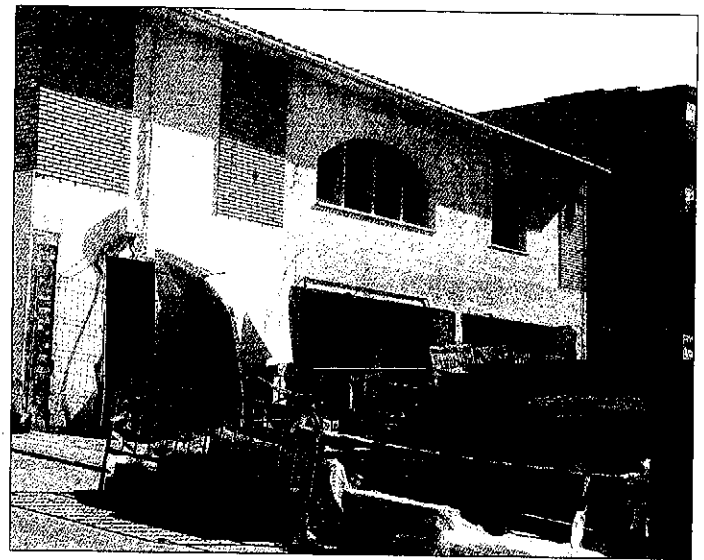
Las obras del centro siguen a buen ritmo y estará listo para junio
