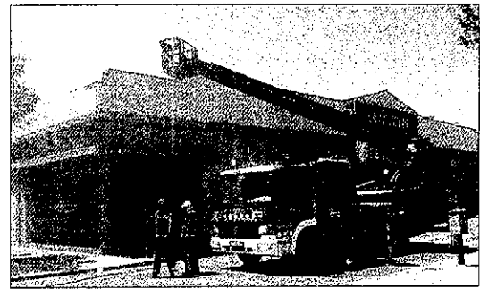
El incendio se originó en una placa solar de la cubierta
