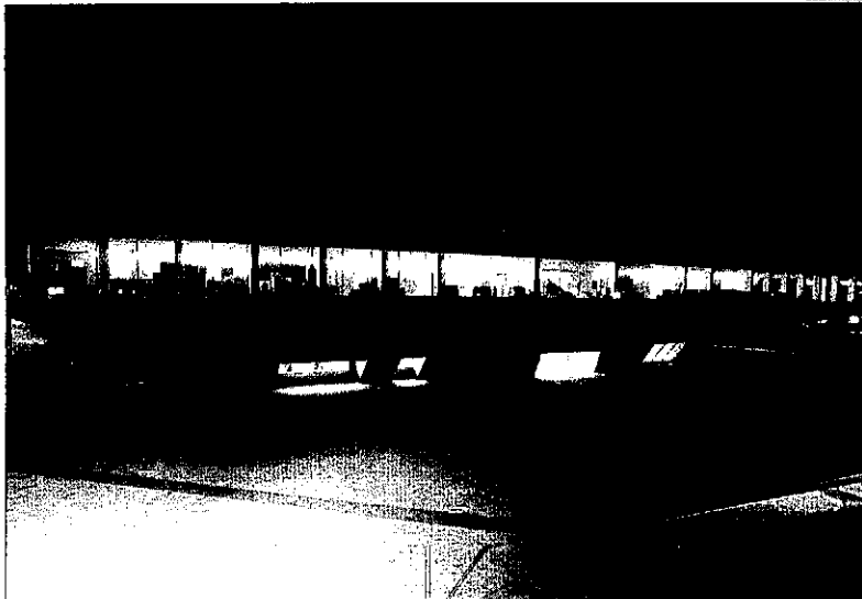
Imatge de la Llotja, les obres de la qual ja es troben pràcticament finalitzades.
