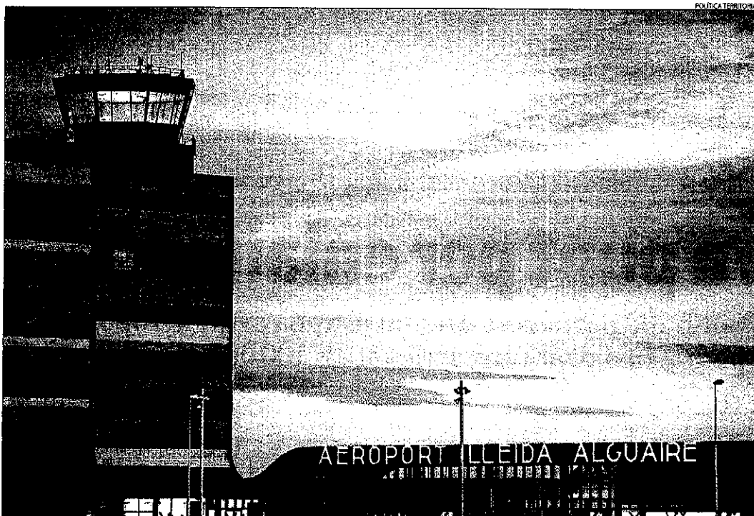
La nova terminal. Imatge de l'edifici de la nova terminal al capvespre. L'aeroport s'anomena Lleida-Alguaire però es promocionarà amb la marca Pirineus.
