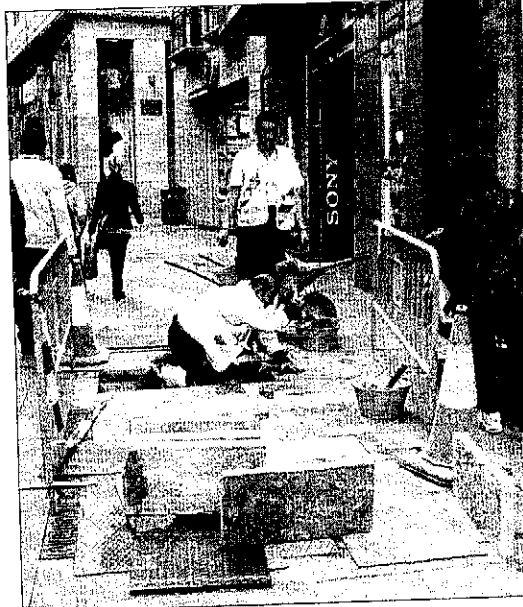
Rajoles de posar i treure ■ El paviment del carrer Major continua necessitant contínues reparacions per la ruptura de rajoles. Ahir, els operaris treballaven al tram pròxim a la Catedral.
