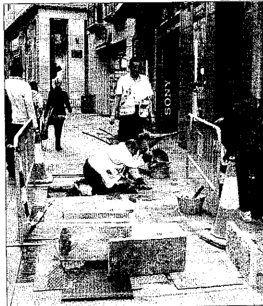
Rajoles de posar i treure ■ El paviment del carrer Major continua necessitant contínues reparacions per la ruptura de rajoles. Ahir, els operaris treballaven al tram pròxim a la Catedral.
