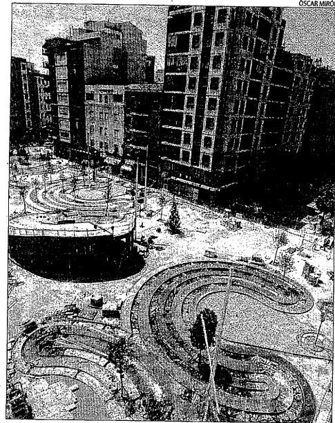
Les obres ja permeten veure la configuració de la plaça.
