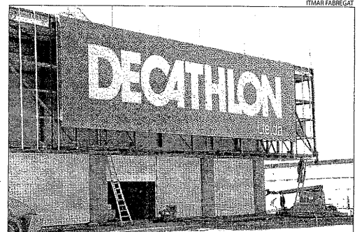
Les obres del Decathlon estan molt avançades.
