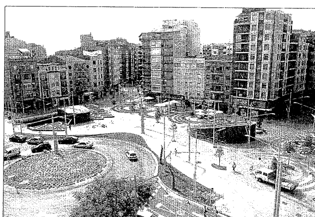
08/10/2010 Recta final. Aquesta imatge mostra l'última fase de les obres, quan tota la zona per als vianants ja estava oberta al públic i només quedaven per executar alguns acabats.
