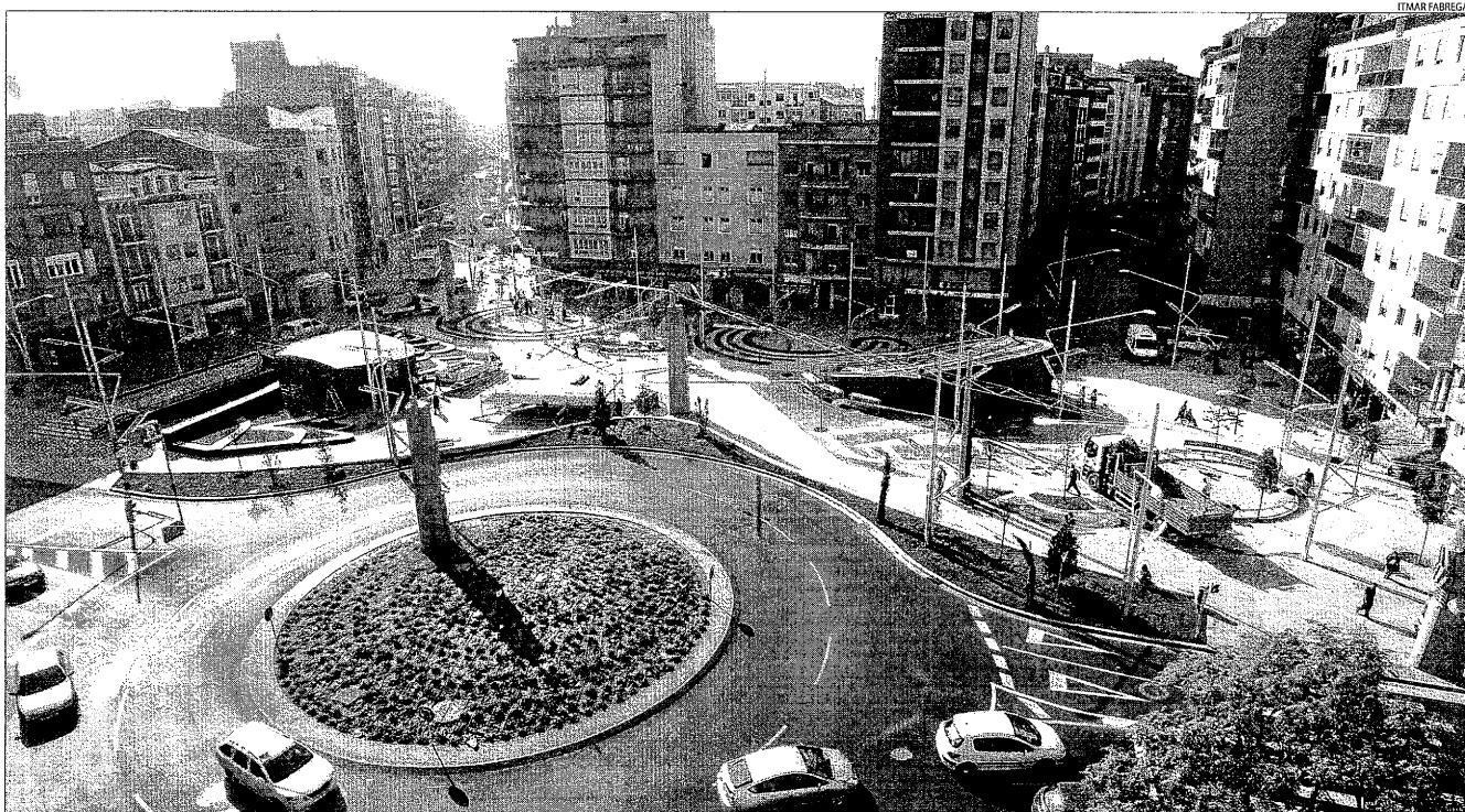
Vista aèria de la nova plaça, que ha guanyat set mil metres quadrats d'espai exclusiu per a vianants.
