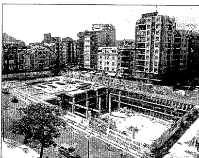
27/08/2009 Pàrquing. Durant l'estiu es va executar el gruix de les obres de construcció de l'estructura de les tres plantes de l'aparcament.
