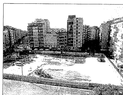
06/11/2009 Urbanització. Una vegada completa l'estructura del pàrquing, els operaris van iniciar els treballs d'urbanització de la nova plaça.
