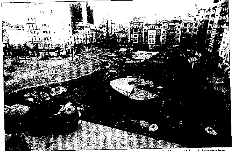
Les obres ja deixen veure la distribució d'espais, amb la incipient rotonda i les sortides del pàrquing.
