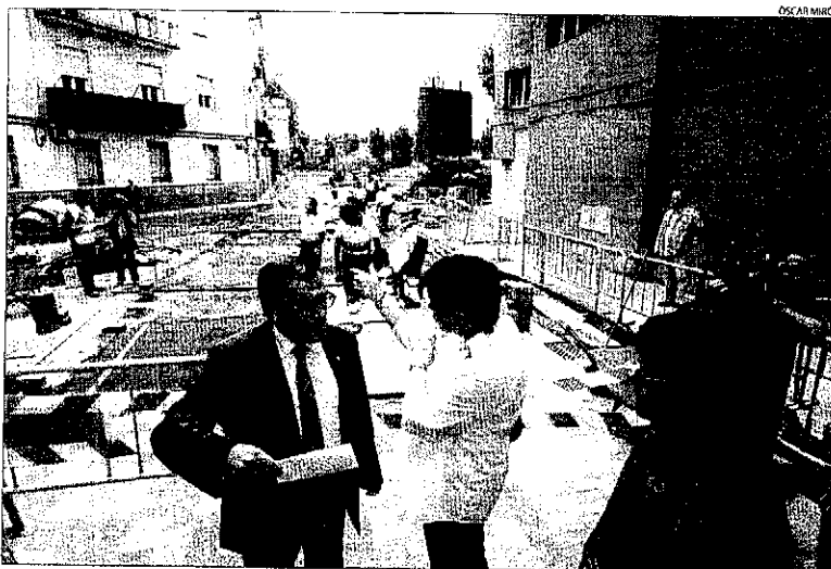
La remodelació de Vila Antònia, enllestida al juliol. L'alcalde, Àngel Ros, va visitar ahir les obres de reurbanització del carrer Vila Antònia, que estaran acabades el mes que ve. La remodelació inclou habilitar una plaça de 400 m² a l'encreuament amb l'avinguda del Segre.
